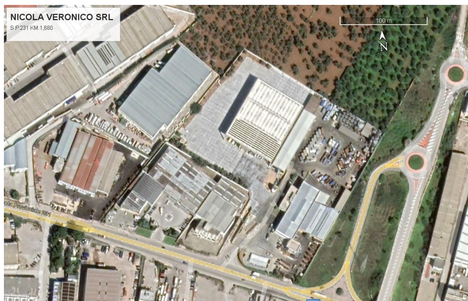
Figura 4 – Foto satellitare impianto
